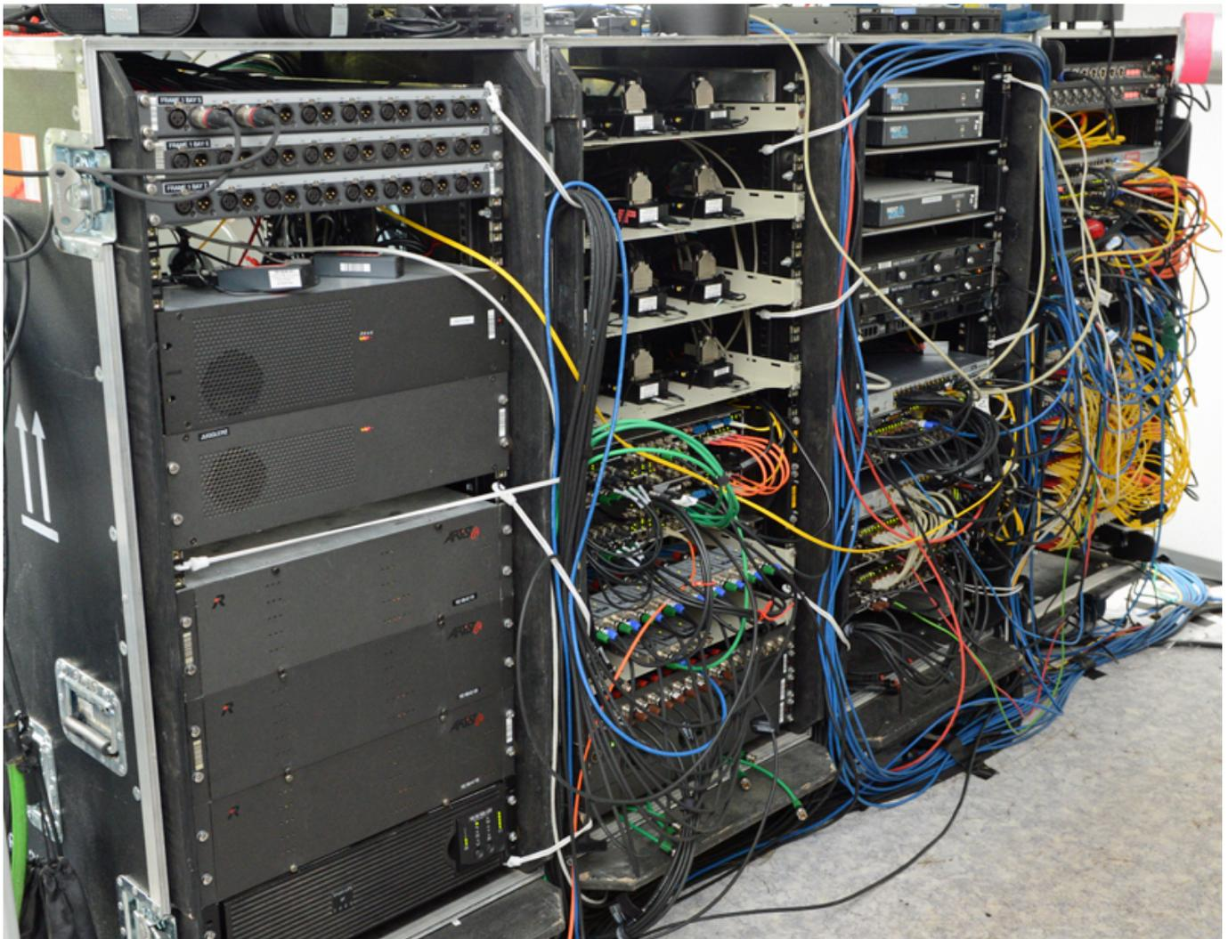
In den gleichen Raum befinden sich auch die Kontrollplätze für die Funk und MediorNet-Kontrolle sowie ein Racks für die zentrale Technik. Im Rack befinden sich unter anderem zwei MetroN-Frames sowie im rechten Rack (s. Abb. oben) noch weiter zwei MediorNet-Frames und auch noch RockNet-Equipment.
