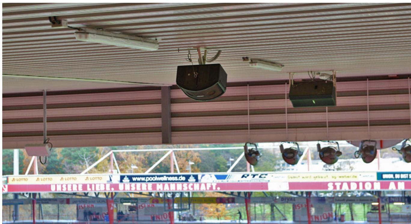
[Abb. oben: Die Beschallung erfolgt mit auf 100-V-System modifizierten Lautsprecher von Bose]
