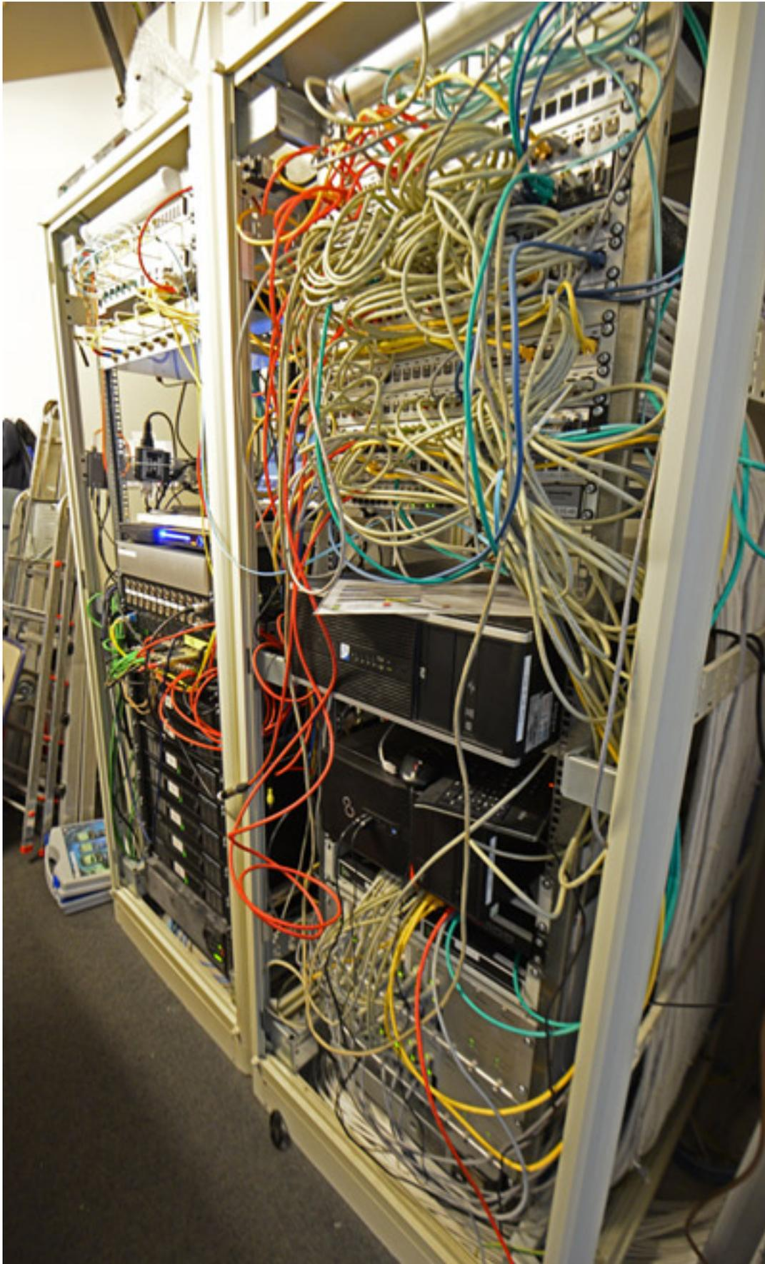
[Abb. oben: Rack im zentralen Technikraum mit Endstufen für die Beschallung]
