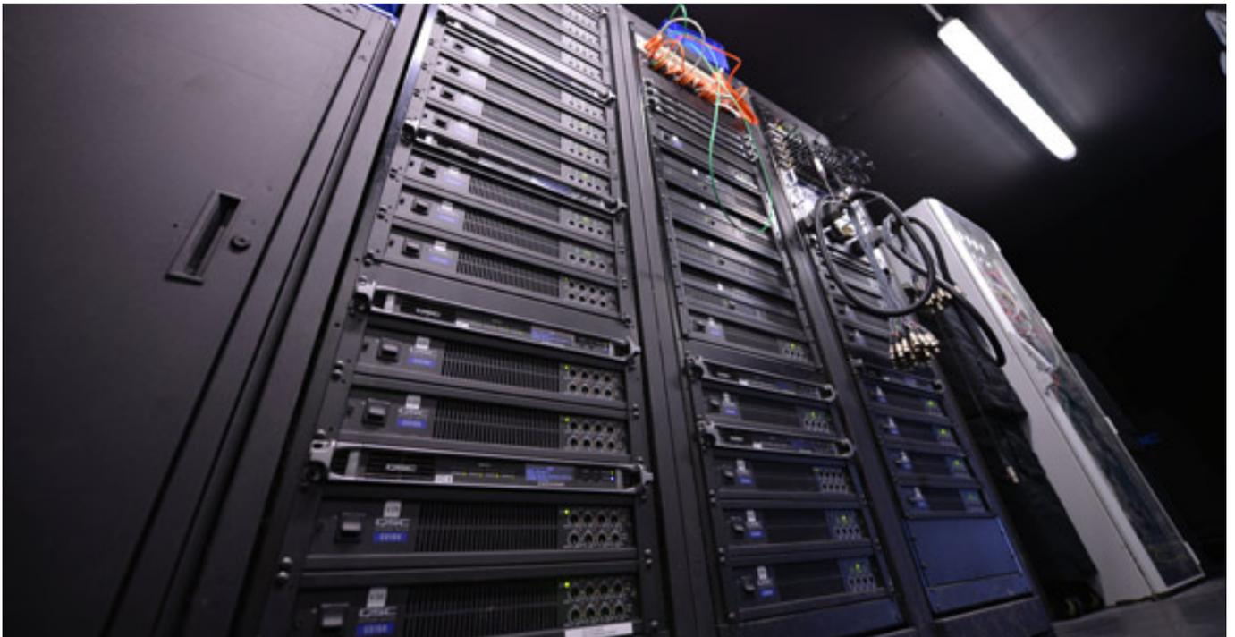
32 Eingangssignale werden auf die Lautsprecher verteilt. Verstärker, Havarie-Überwachung und Core befinden sich in einem Technikraum hinter der Bühne (s.
