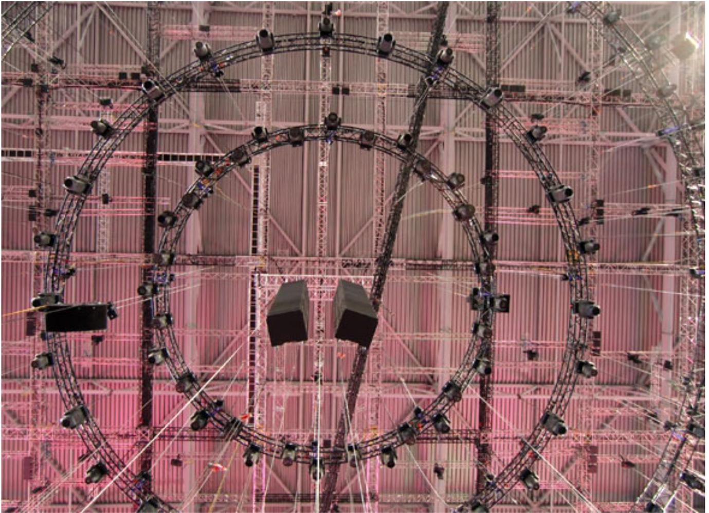
Der erste Ring beschallte den Innenraum unmittelbar um die Bühne und bestand aus 11 Arrays der d&b Q-Serie. Der zweite und dritte Ring deckte den restlichen Innenraum sowie den Unterrang ab. Hierfür waren weitere 8 respektive 6 Arrays d&b J-Serie installiert. Zur Versorgung des Oberrangs wurden weitere 13 Arrays der d&b T-Serie geflogen.
